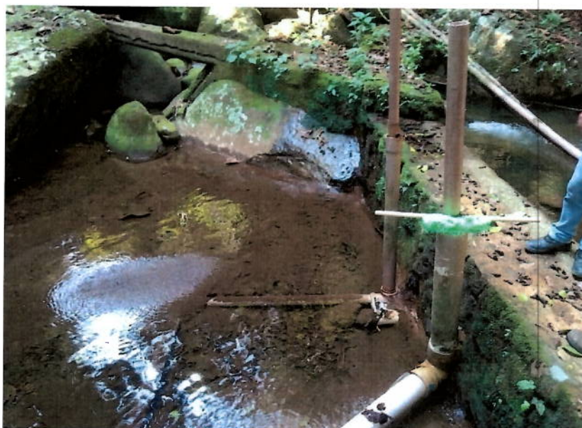
Foto 10 – barragem de Conceição de Jacaré II.
