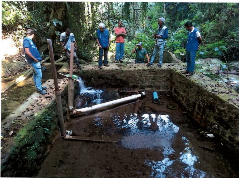
Foto 9 – barragem de Conceição de Jacaré II.
